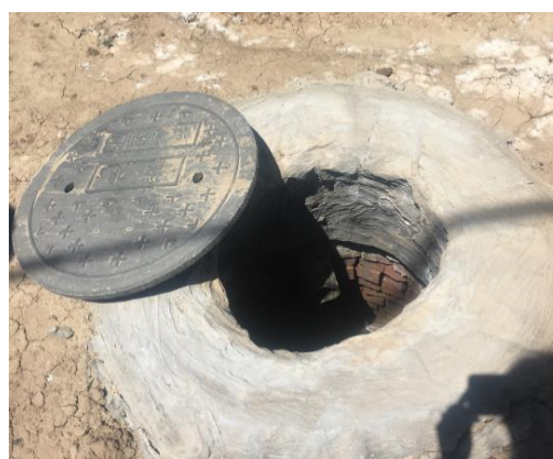
生活废水化粪池
