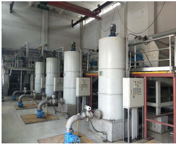
一期提标改建污泥脱水机房
