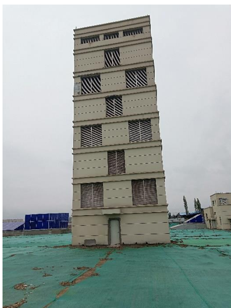
有组织废气排气筒
