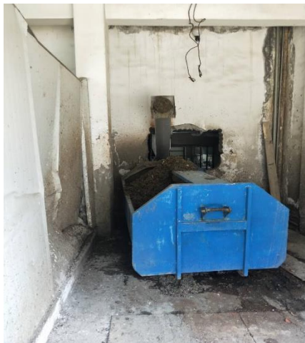
一期提标改建栅渣处理
