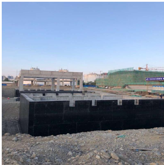
甲醇储罐池底防渗防水处理
