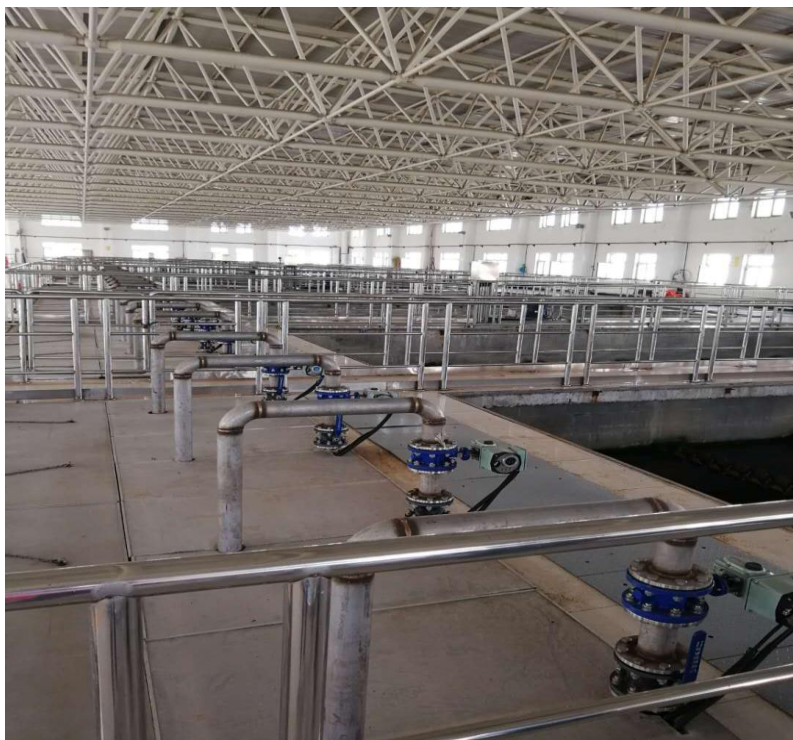
图 3-6 一期单体改造工程
