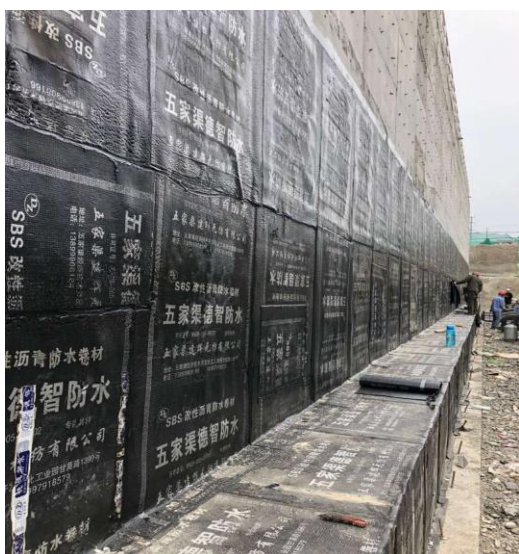
生物池防水防渗处理
