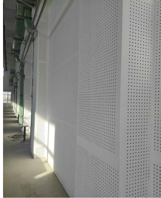
风机房吸音墙面设计
