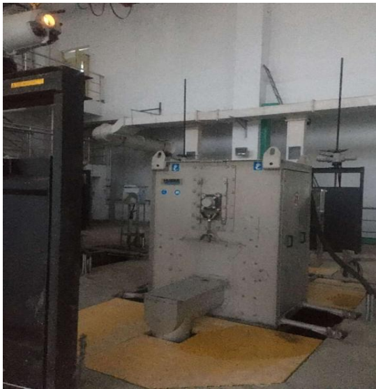
精细格栅间加盖挡板
