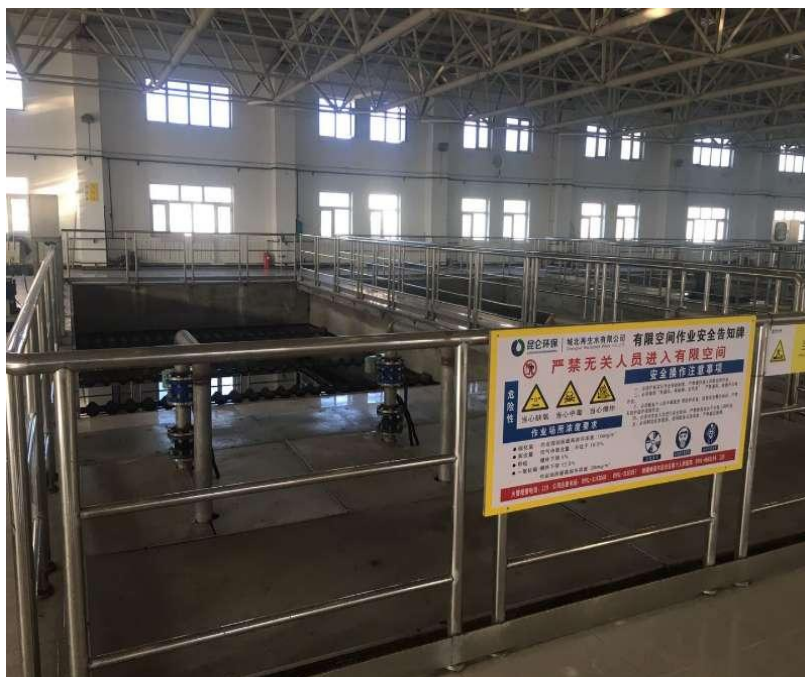
图 3-7 二期单体改造工程
